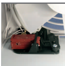
Termoattuatore per l'apertura elettrica delle alette
