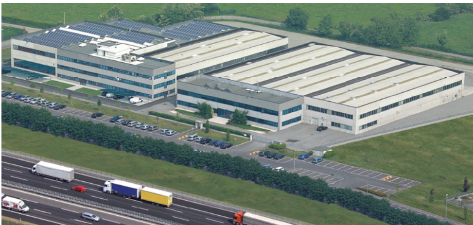
The headquarter of Maico Italia Spa, Lonato del Garda (Brescia)
